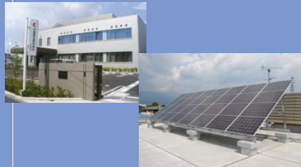
▲松本営業所の屋上に設置された太陽光パネル
