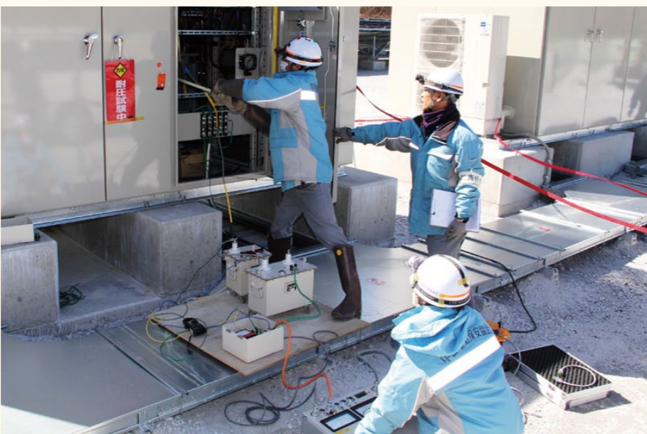
▲高圧受電設備の竣工検査
