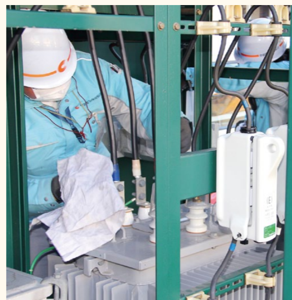
▲高圧回路の目視点検及び清掃
