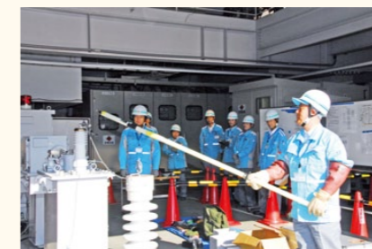
▲特別高圧設備竣工検査
