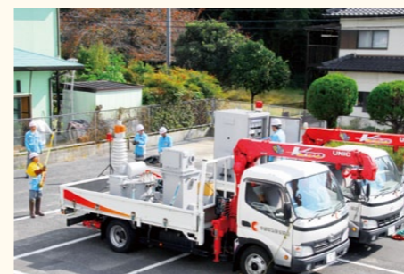
特別高圧電気設備の絶縁耐力試験
