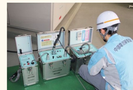
CVケーブル活線劣化診断
