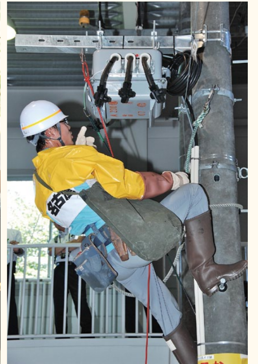
▲テクノピック(保安部門・柱上作業)
