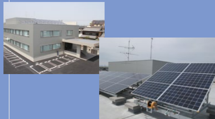
▲三重支店ソーラービルの屋上に設置された研修機能付き太陽光パネル
