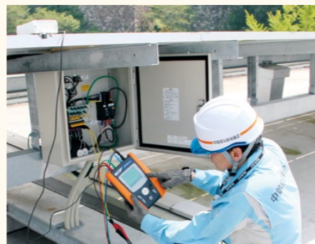
▲パワーコンディショナーテストによる電力品質測定
