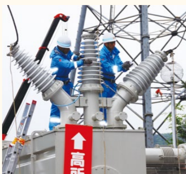
▲特高設備の外観点検と清掃
