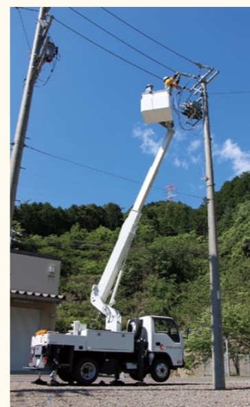
▲構内架空電線路の点検
