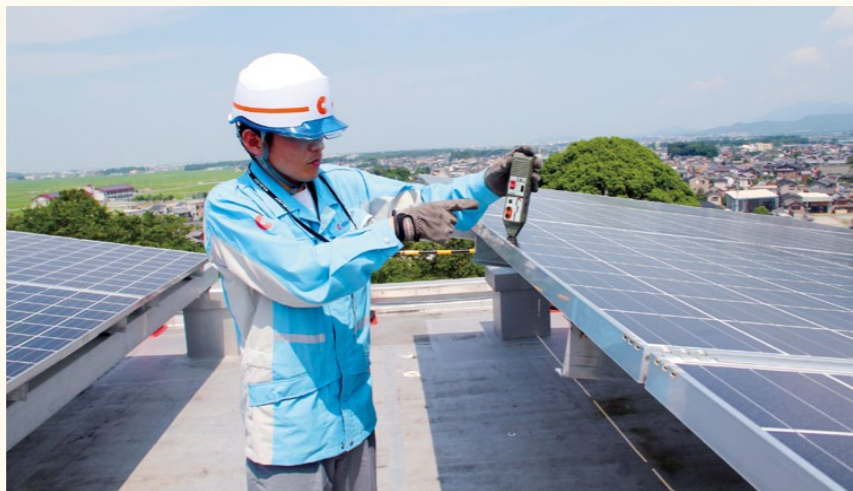
▲セルラインチェッカーによる断線箇所探査
