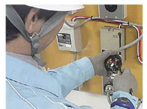
コンセントプラグの結線確認
