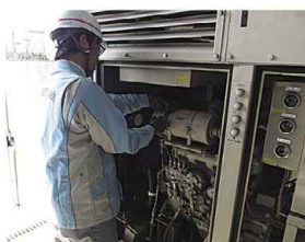
エアフィルターの整備
