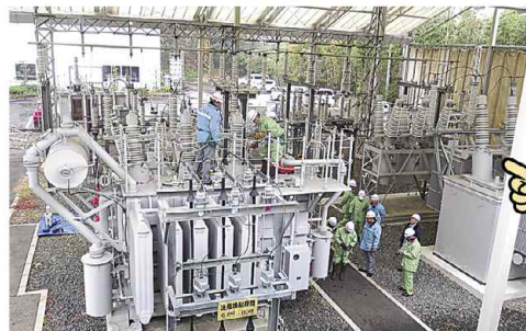
高所部分の変圧器点検実習
