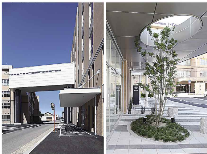
(左)棟をつなぐ渡り廊下 (右)玄関アプローチ
