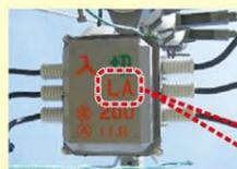
●柱上機器内蔵型(高压気中負荷開閉器)
