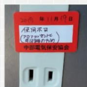
写真④ 使用禁止措置を施した壁コンセント
