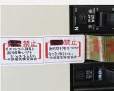
写真③ 送電禁止シールを貼付した分電盤
