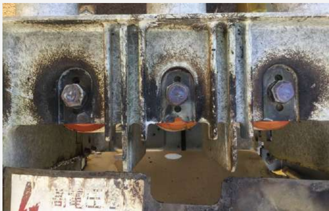
写真 原因のリーク痕が発見された真空遮断器
