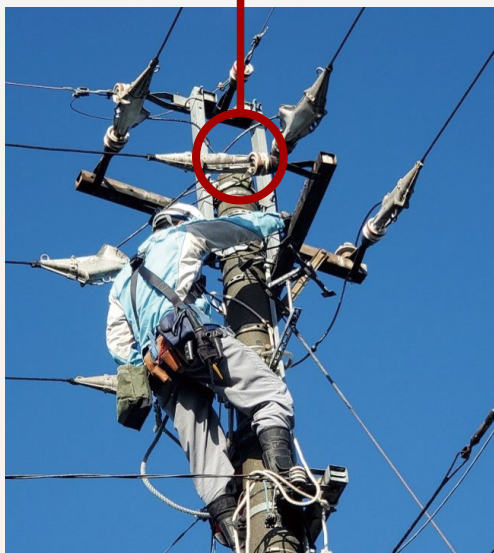
高圧耐張碍子に付着した鳥糞を清掃する様子
