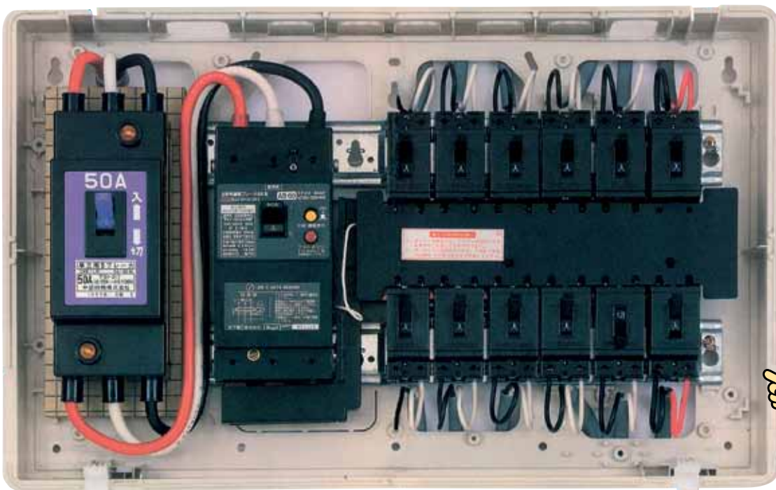
サービスブレーカー 漏電ブレーカー
